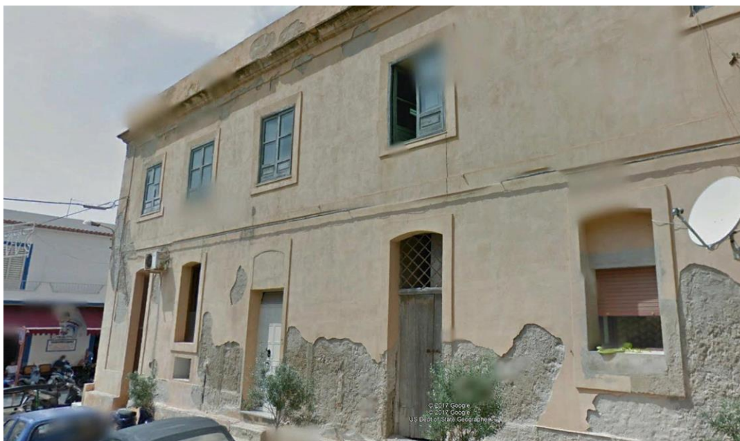
Foto n.3 - Palazzo n.7 Via Anfossi : particolare del degrado dell'intonaco esterno
